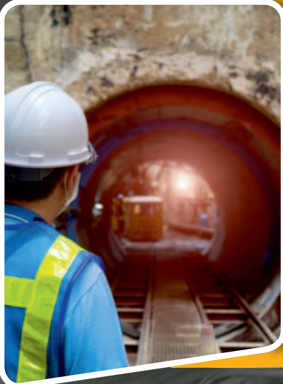
Tunelling and Temporary Reinforcement Tünel Açma ve Geçici Güçlendirme
